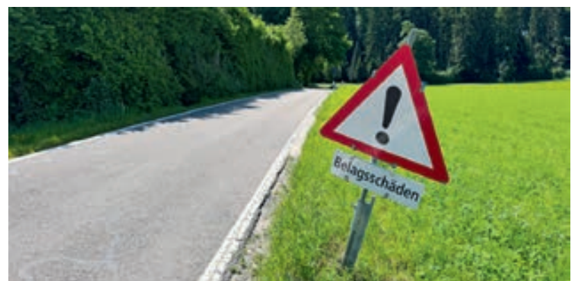
Havariert: Die Chalenstrasse Richtung Zumikon
