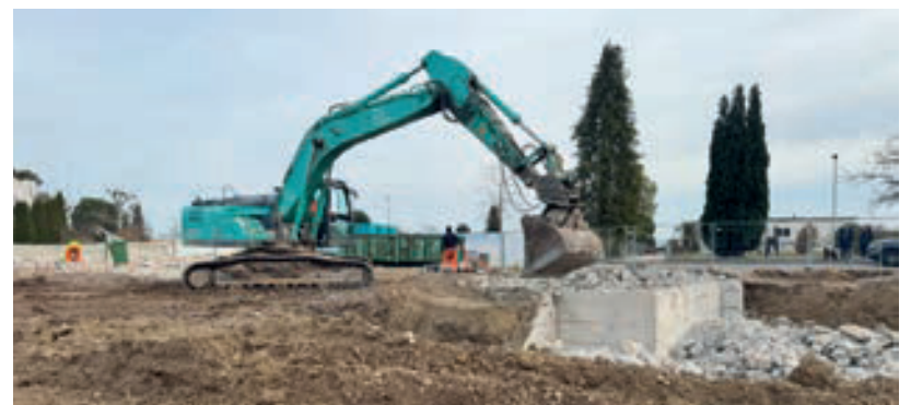
Den Geistern den Gar ausgemacht: die Abbruchbagger verrichten ganze Arbeit.
